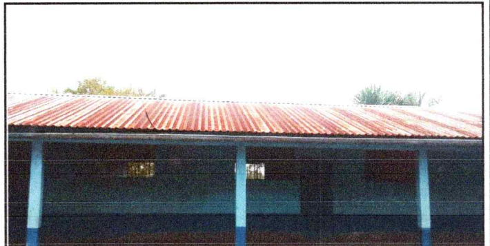
Foto 6: Módulo 6 - necesita remozar la pintura del techo, de las paredes interior y exterior y aplicación de anticorrosivo de puertas y balcones de metal.
