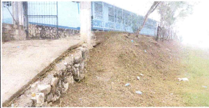
Foto 1: Muro de contención, continuidad del muro perimetral
