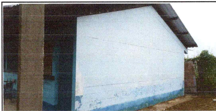
Foto 5: Módulo 5 - se necesita remozar pintura interior y exterior, anticorrosivo para puertas y balcones.
